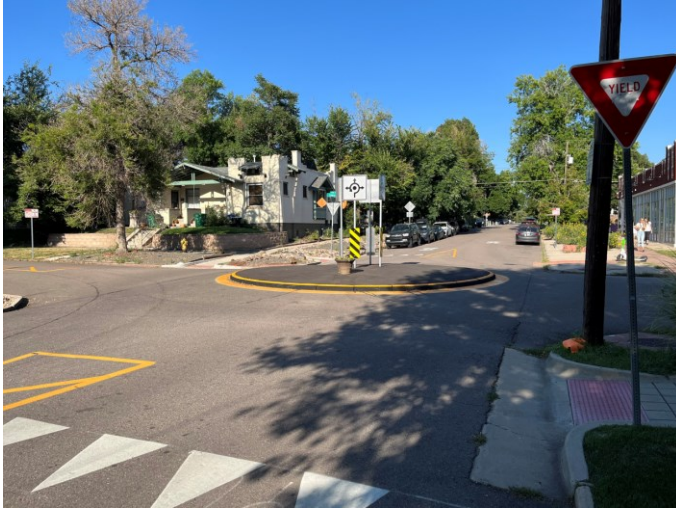
Example of a Mini Traffic Circle
